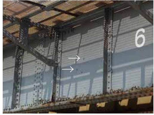
図 10. 山陰本線 新川鉄橋 銃弾跡
